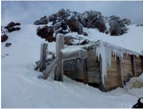
Fig. 3. Punta Linke. La baracca (3629 m) dopo l'intervento di ricostruzione e restauro.
