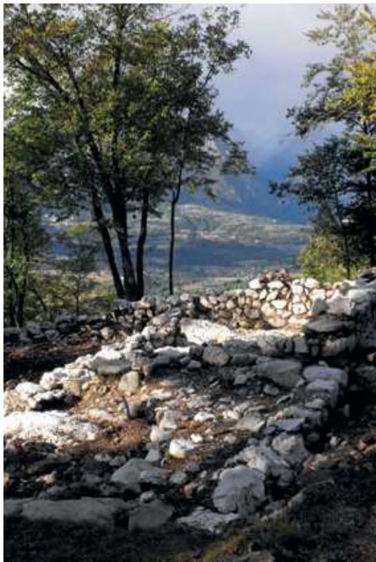
Fig. 17. Monte San Martino. Settore 5: contrafforte esterno (prospetto laterale Nord); situazione dopo la rimozione di crolli e del materiale di copertura (foto Sonia Schivo).
