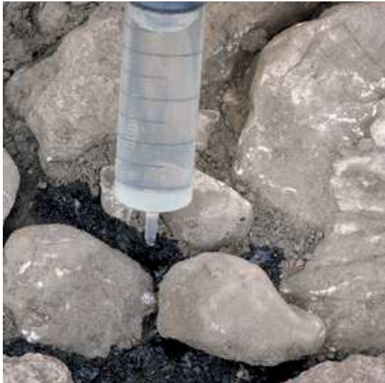
Fig. 1. Cles, tracciato viario. Consolidamento con infiltrazione di resina epossidica bicomponente a bassissima viscosità.
