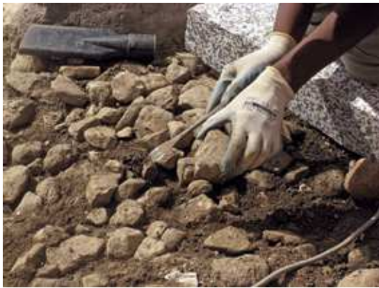
Fig. 2. Cles, tracciato viario. Ricollocazione dei ciottoli smossi con impasto a base di calce idraulica (foto di Ambra Co.Re.).
